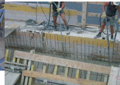
Betonverdichtung im Hochbau mit Elektro-Innenvibratoren Serie NCZ
