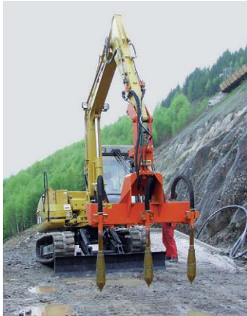
Bagger bestückt mit Hydraulik-Innenvibratoren Serie NHR zur Verdichtung von Massenbeton
