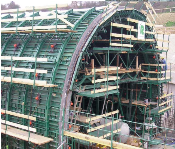
Tunnelschalung mit Druckluft-Außenvibratoren Serie NVT
